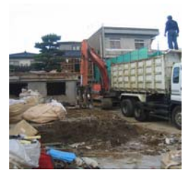
解体作業の現地
