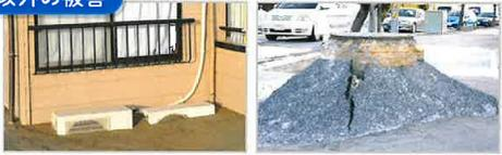
傾斜や噴砂による埋没(左)、敷地内の排水管やガス管などの破損・詰まり、マンホールの浮き上がり(右)など
