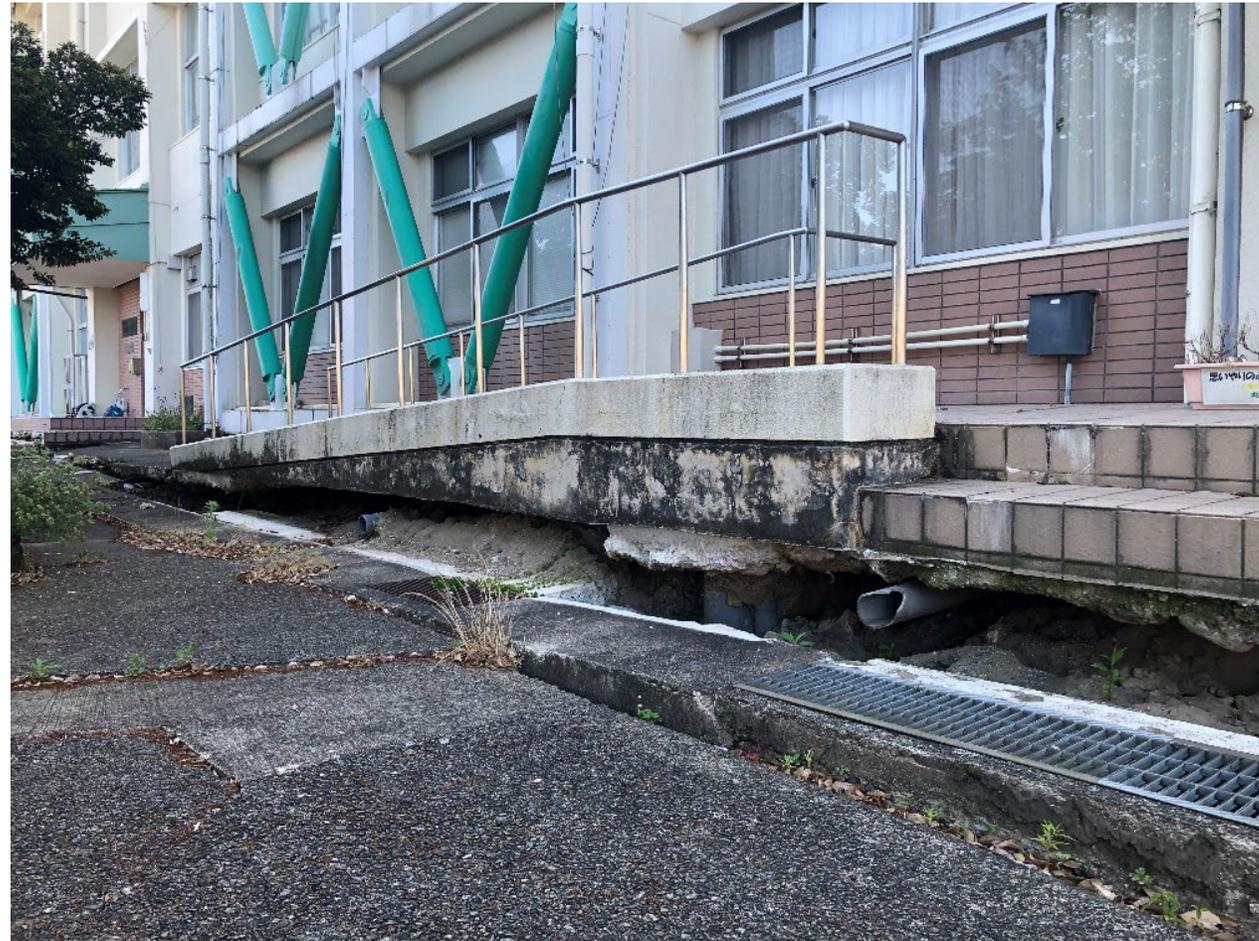
西荒屋小学校の被害状況 建物は耐震化対策されているが周辺地盤が液状化によって沈下し、埋設管が破壊されている
